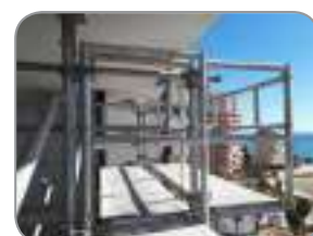
Las piezas de Tempo Balcón se pueden combinar con las piezas de Tempo para conformar un andamio Tempo de 4 m de altura
